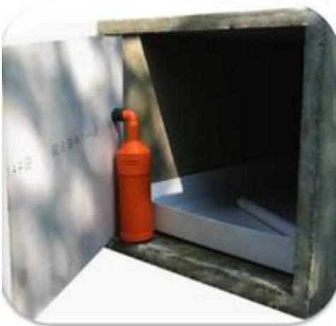
**Immagine n°8:** Esempio di trasformazione di loculo esistente nel tipo "aerato". Sono visibili il filtro depuratore (rosso) collegato alla lastra di sigillo e la vaschetta raccolta liquidi (bianca) inserita internamente al vano esistente.
